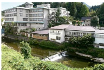
土砂堆積や水害の原因となっている堰
