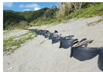
侵食対策として設置されている土のう
